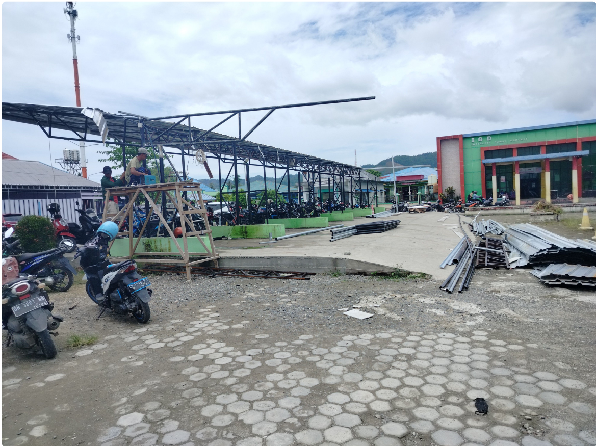
Bangunan Atap yang menjadi tempat parkir kendaraan bermotor para pengunjung keluarga pasien RSUD itu kembali di lakukan perbaikan oleh pihak Rumah Sakit Buol
